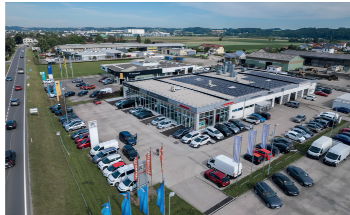
Aus der Vogelperspektive sieht man die Größe des Autohauses Slawitscheck in Amstetten, das weiterhin von Wachstum geprägt ist. Da bedarf es eines in Kfz-Versicherungsfragen kompetenten Partners wie carplus, der den Weg der Expansion mit seinem Know-how begleitet
